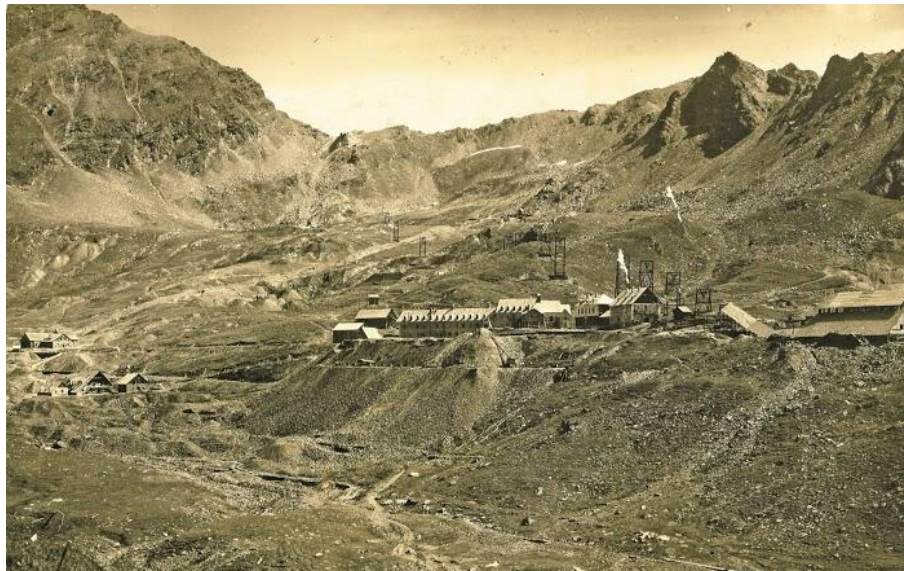
Abb.2.1: Historisches Foto des Knappendorfes St. Martin am Schneeberg, als der Schneeberg noch in seiner letzten Abbauphase in Betrieb war. Die Materialseilbahn, deren Pfeiler gut zu erkennen sind, wurde zwischen 1924 und 1926 angelegt (Haller H & Schölzhorn H, 2000). Das genaue Aufnahmedatum ist unbekannt. (Bild: Widmann H).
